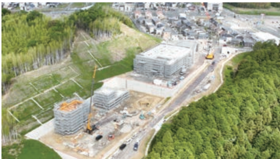
※工事の状況は毎月消防本部HPで公開しています。【令和7年5月22日撮影】
