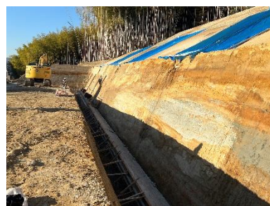
（ブロック積み擁壁）
