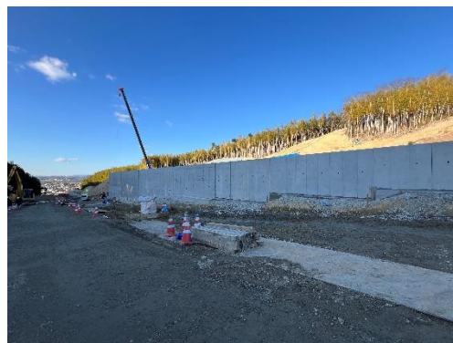
擁壁外側から撮影
