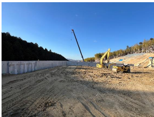
擁壁内側から撮影
