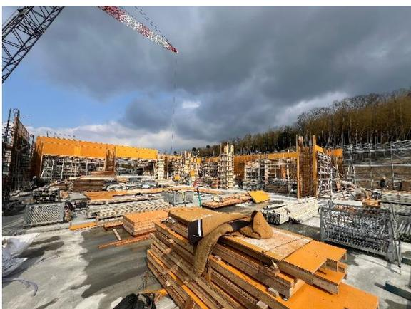
【3階壁型枠建込の作業状況】
