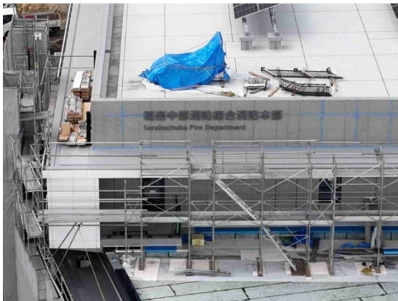
【本棟東側銘板の設置状況】
