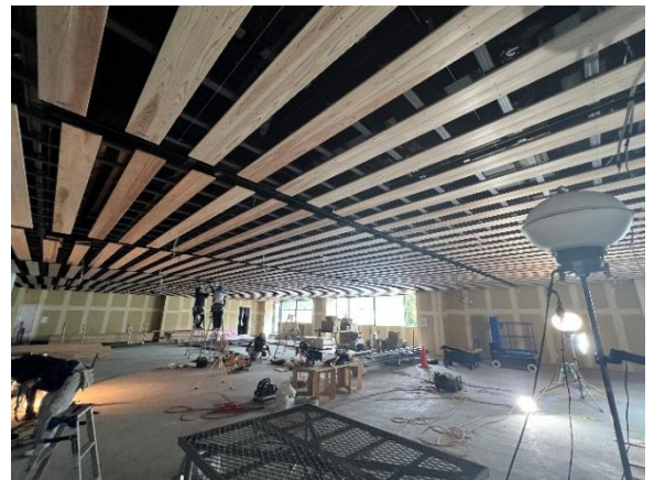
【2階事務室木製ルーバー天井の設置状況】
