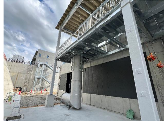
【車庫棟北側マンホール救助訓練施設の状況】
