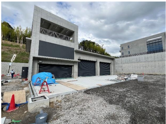
【車庫棟の状況】
