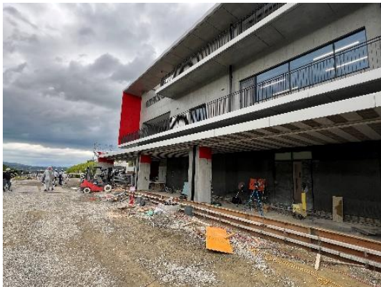
【本庁舎南側玄関庇の状況】
