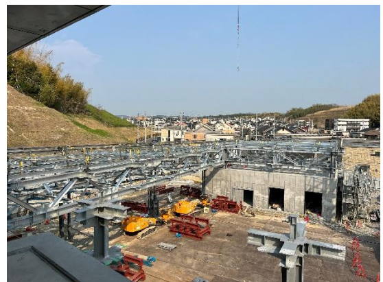
【ガレージ屋根部トラス梁の状況】
