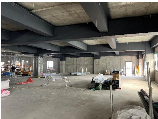
【2階事務室の状況】
