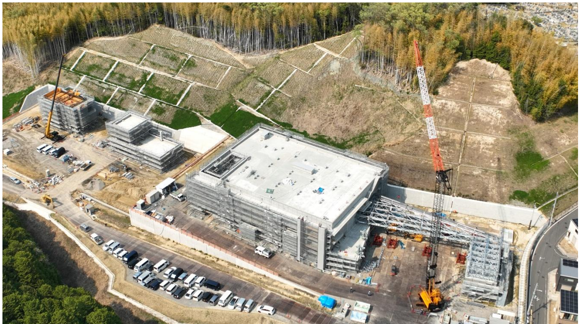
【4月17日現在の進捗状況（全景）】
