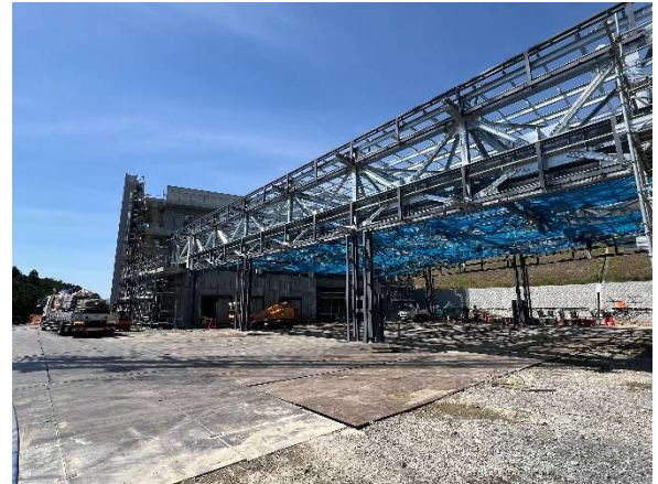
【本棟車庫鉄骨トラス梁の状況】
