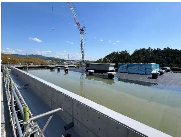
【本棟屋上アスファルト水張検査の状況】
