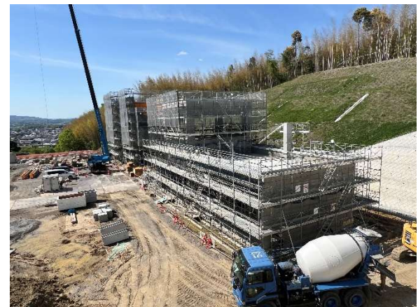
【車庫棟、訓練棟の状況】
