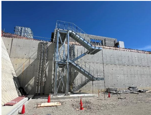
【2段目屋外階段の状況】
