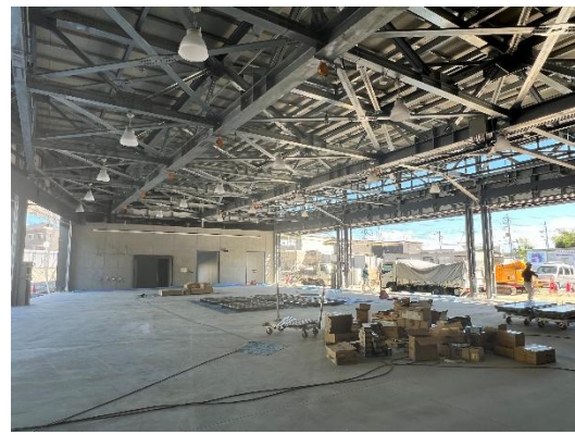
【ガレージ床面（防塵加工）の状況】
